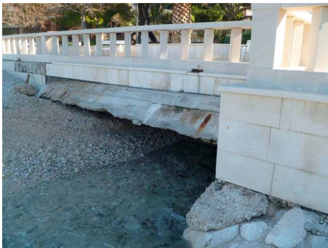
Slika 2.1-6. Završetak bujice „Suhi potok“ u zidu šetnice.
